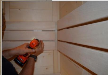
Ensuite, à l'aide de vis 3,5x40, fixez le support arrière aux sections d'éléments muraux. Positionnez vos vis dans les motifs verticaux entre les lattes de manière à ce que les vis soient dissimulées.
