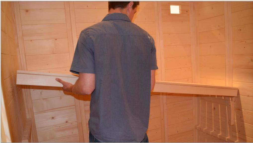
**Étape 22** - Placez le banc supérieur sur les supports du banc supérieur. Une fois le banc supérieur en place, vissez-le dans les supports de banc droit et gauche à l'aide de (4) vis 4x60, deux de chaque côté et entre les lattes. Ensuite, utilisez (4) vis 4x60 et fixez l'arrière du banc au mur arrière par le dessous du banc. Placez une vis dans chaque section d'élément de mur en perçant à travers l'arrière du banc.
