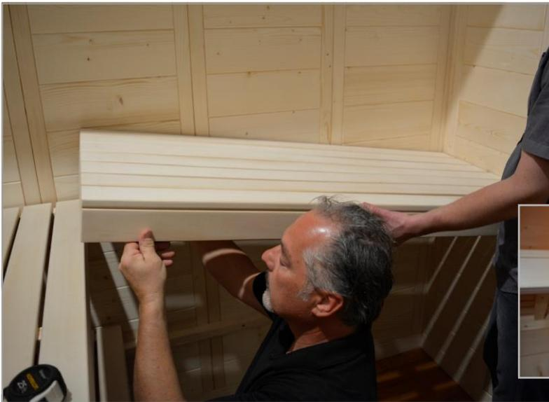
**Étape 25** - Positionnez le banc latéral en plaçant l'une de ses extrémités sur le support de banc que vous avez installé à l'étape 24. Avec une personne tenant le banc, positionnez l'autre extrémité de façon à ce qu'elle soit au même niveau que le banc supérieur arrière. À l'aide de vis 5x70, fixez le banc latéral au banc arrière par le côté inférieur. Ensuite, à l'aide de vis 4x60, fixez l'arrière du banc latéral aux sections d'éléments muraux par le dessous
