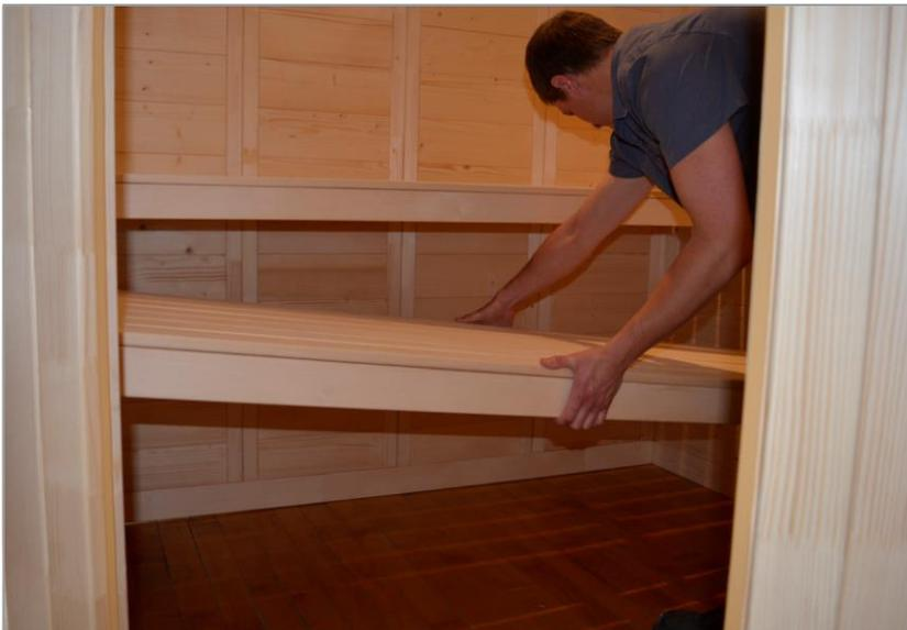
**Étape 23** - Placez le banc inférieur sur les supports du banc inférieur. Étant donné que le banc inférieur est destiné à glisser vers l'intérieur et vers l'extérieur (il peut être utilisé comme une marche ou comme un banc complet), il ne doit pas être vissé en place.
