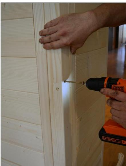
**Étape 5** - À l'aide d'une perceuse sans fil et d'une mèche de taille appropriée (incluse), utilisez des vis 6x20 et fixez le poteau d'angle à 90° à l'élément court et large.
