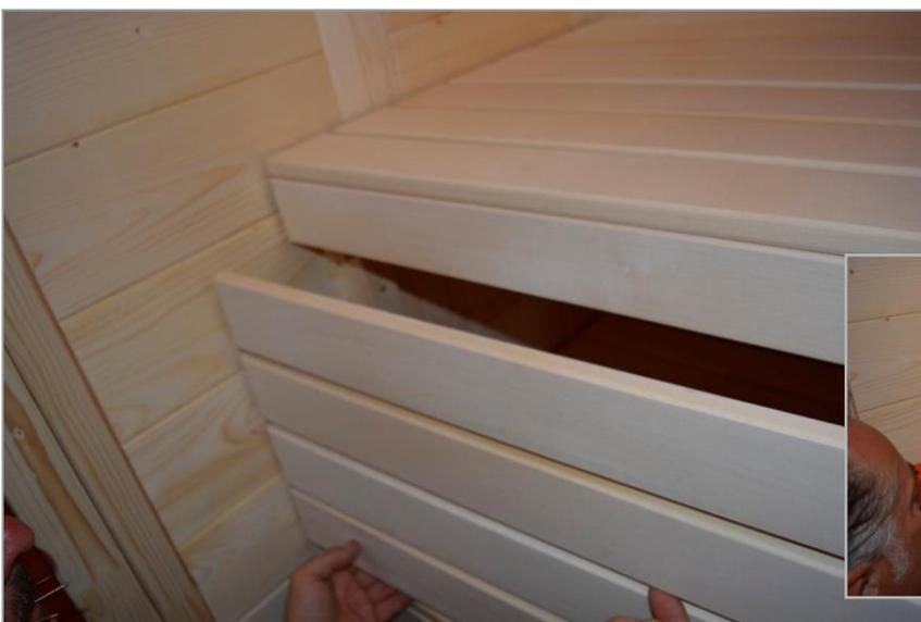
**Étape 27** - Positionnez le support dorsal inférieur (4 lattes) au-dessus du banc inférieur et contre les supports verticaux que vous avez installés à l'étape 21. En maintenant le support du banc inférieur serré contre le banc supérieur, fixez-le aux supports verticaux à l'aide de vis 3,5x40.
