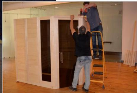
NOTE: Les pièces de moulure ne sont pas prédécoupées et doivent être découpées à l'aide d'une scie à main. Si le sauna est placé dans un coin de la pièce, il est courant de n'installer la garniture que sur les côtés visibles.
