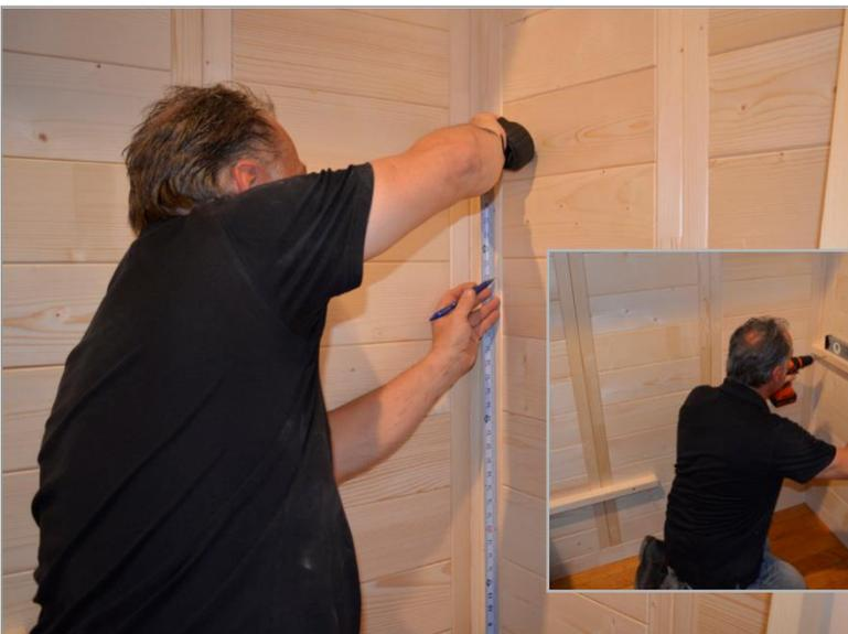
**Étape 24** - Pour l'installation du banc latéral, vous devez Placer et installer un support de banc sur le mur intérieure avant du sauna pour une extrémité du banc. L'autre extrémité sera fixée à l'avant du banc supérieur arrière, créant ainsi un banc supérieur en forme de "L".
