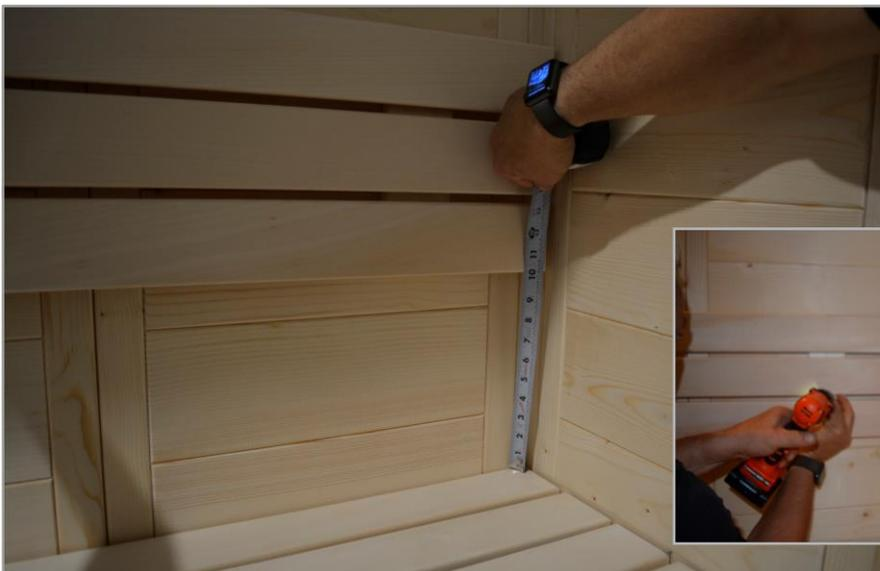
**Étape 26** - Mesurer 10" au-dessus de l'arrière et les bancs supérieurs latéraux et faites une marque au crayon. Placez l'un des supports de dossier du banc supérieur (3 lattes sur chaque support de dossier) au-dessus de chaque banc et assurez-vous qu'il est de niveau.
