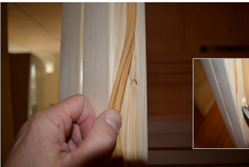
**Étape 32** - Au milieu du cadre de la porte, retirez la bande d'étanchéité et trouvez le trou pré-percé pour l'aimant. Trouvez l'aimant dans le kit de quincaillerie et serrez-le dans le trou à l'aide d'une pince. L'aimant est réglable et peut être desserré ou serré selon les besoins. Coupez la
