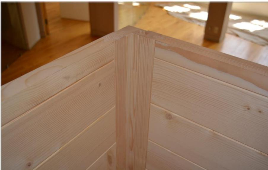
**Étape 4** - Vérifiez que les éléments de section de mur sont d'équerre par rapport aux rails, perpendiculaires les uns aux autres, et que le dessus plat des éléments de mur et les poteaux d'angle sont alignés.
