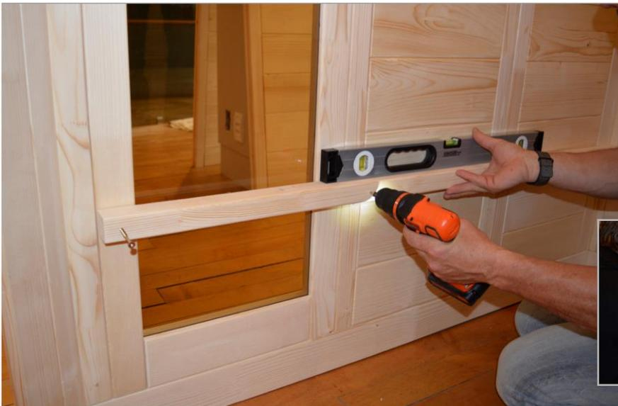
**Étape 20** - Pour les supports inférieurs du banc, répétez l'étape 19, mais mesurez à partir du sol 16" et faites une marque. Installez les supports de banc plus longs de 52 po à droite et à gauche, en notant que le support de banc inférieur sur le mur plus court de gauche traversera la fenêtre et sera vissé dans le panneau de la fenêtre.
