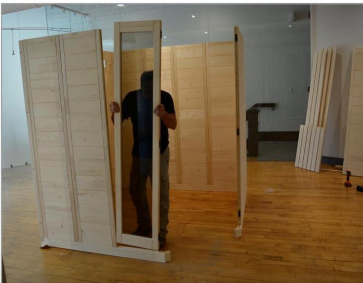
**Étape 12** - Installer l'élément de mur vitrée étroite avec les clips de bordure orientés vers l'ouverture de la porte.
