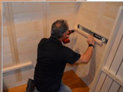
Pour installer le support de banc, mesurez 34" à partir du sol sur le mur avant et faites une marque avec un crayon. Ensuite, à l'aide de vis 5x70, fixez le support de banc supérieur en utilisant un niveau pour vous assurer qu'il est parallèle au sol.
