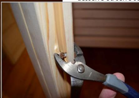
bande d'étanchéité pour permettre l'insertion de l'aimant, puis réinsérez-la dans la rainure.
