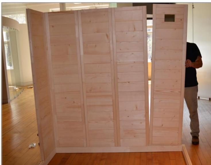
**Étape 6** - Placez les 3 éléments muraux de largeur suivants (L) sur le mur arrière, en utilisant l'élément avec l'ouverture carrée à l'extrême droite du mur arrière. Aucune vis ne sera utilisée dans ces éléments, mais assurez-vous que les éléments sont fermement placés sur une avec les rails inférieurs et que les sections supérieures plates sont alignées les unes aux autres.
