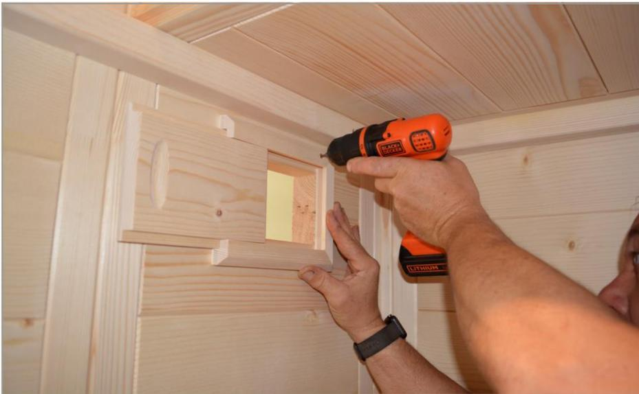
**Étape 28** - Localisez le couvercle de l'évent et placez-le sur l'ouverture du mur. Fixez-le avec (40) vis 3,5x40.
