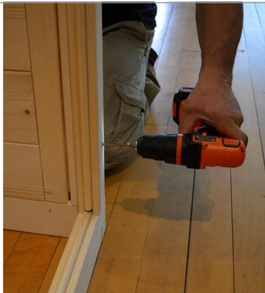
**Étape 7** - Placez un autre poteau d'angle à 90° sur l'élément d'extrémité et fixez-le avec des vis 6x20.
