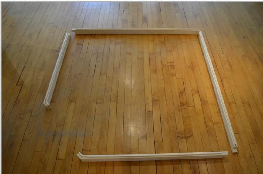
**Étape 1** - Localisez les (4) rails inférieurs et positionnez-les comme indiqué. Faites chevaucher les joints d'angle et assurez-vous que les rails sont d'équerre les uns par rapport aux autres. Percez un trou pilote de 1/8" dans les joints d'angle et fixez les rails les uns aux autres à l'aide d'une seule vis 5x70 dans chacun des 3 angles.
