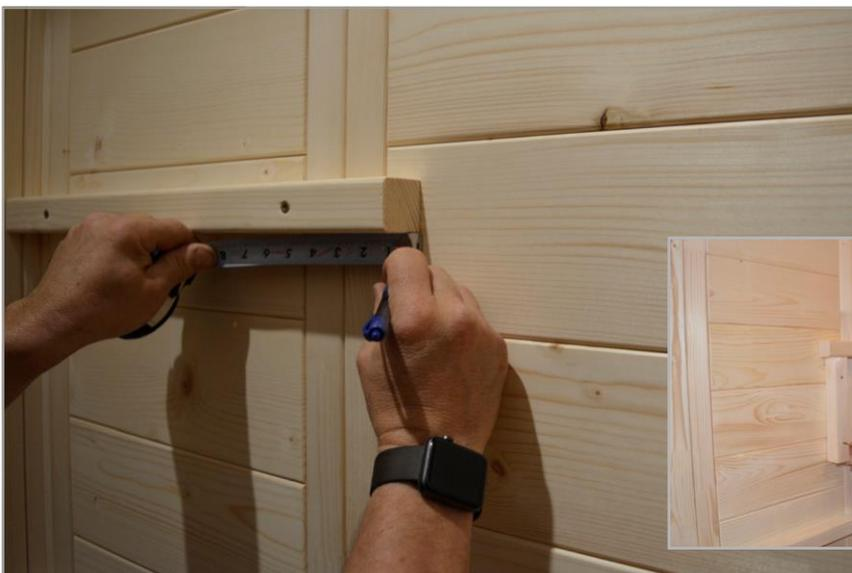
**Étape 21** - Vous allez maintenant installer les supports inférieurs du dossier du banc. À partir de l'avant des deux supports supérieurs du banc que vous venez d'installer, mesurez 3/4" en arrière et faites une marque. Ensuite, installez les deux supports inférieurs du dossier du banc
