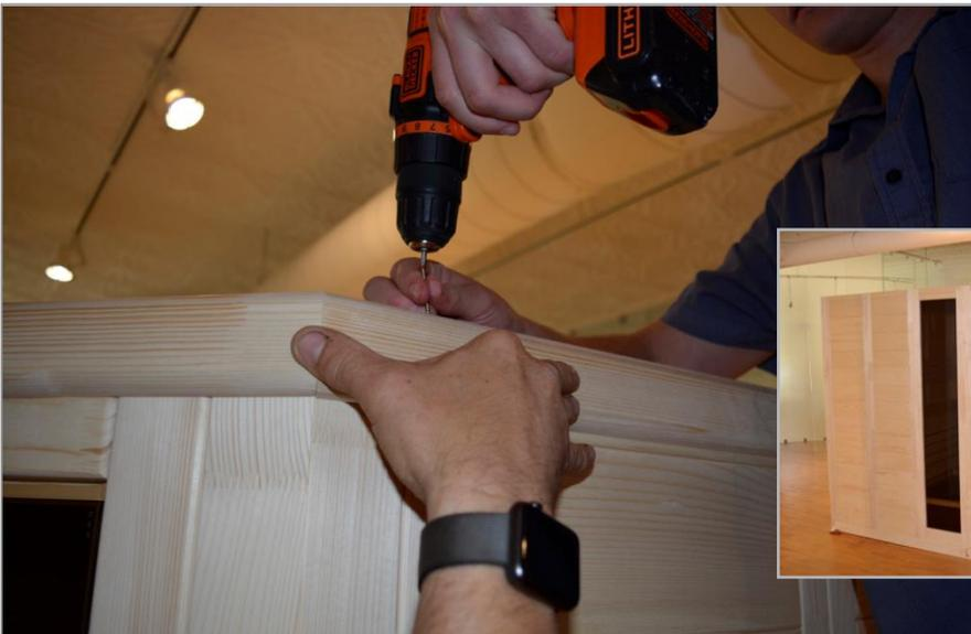
**Étape 29** - Localisez les pièces extérieures de moulure du plafond. Elles seront fixées au périmètre supérieur extérieur du sauna. Les pièces forment un "L" autour du bord supérieur et seront vissées aux sections du plafond par le haut à l'aide de vis 3,5x40.
