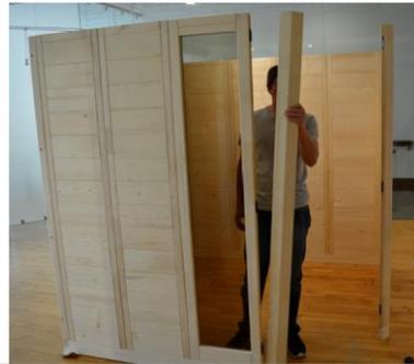
**Étape 13** - Installez les (2) poteaux d'angle à 45° sur les éléments de mur étroits (l'un en bois, l'autre en verre) qui encadrent l'ouverture de la porte. Une fois que le poteau d'angle est en place, vous pouvez le caler à l'aide d'un maillet en caoutchouc.
